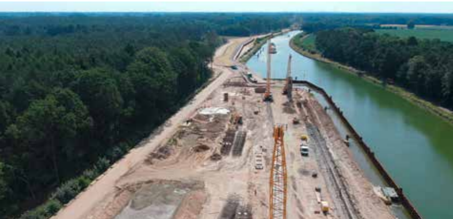
Baustelle am 25. Juni 2019
