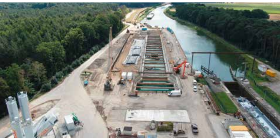
Baustelle am 4. August 2020
