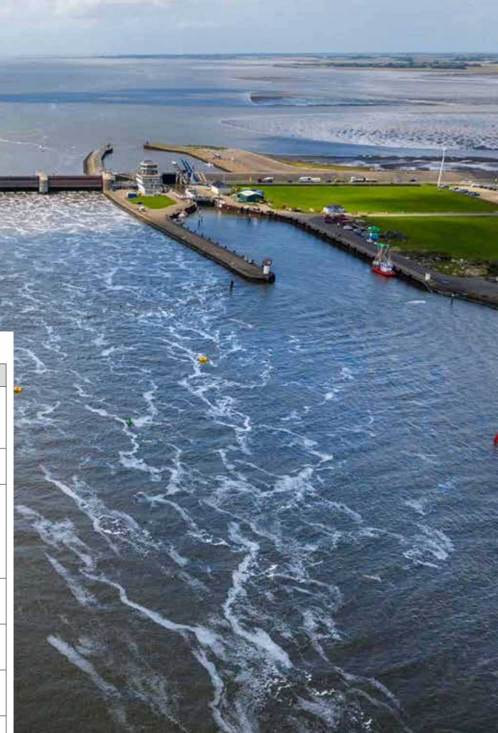
Das Eidersperrwerk bei Tönning
