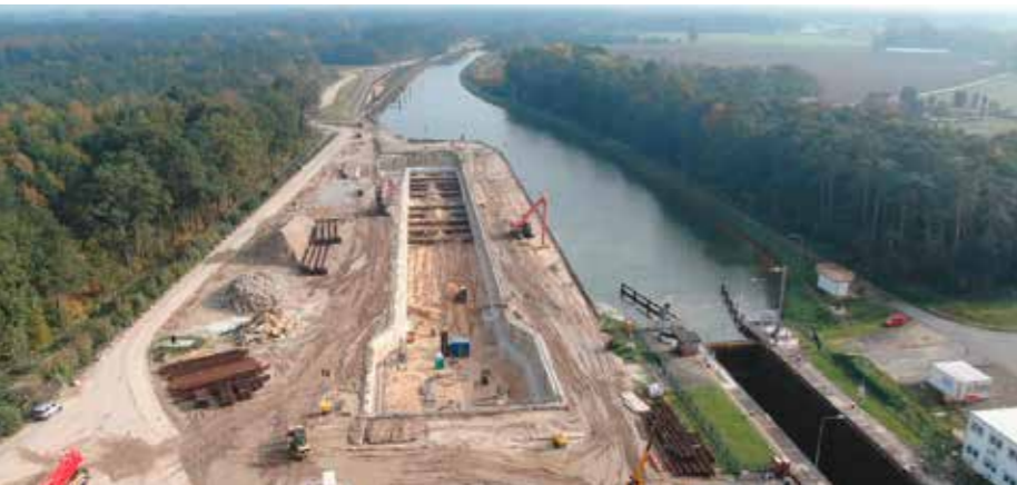
Baustelle am 23. Oktober 2019
