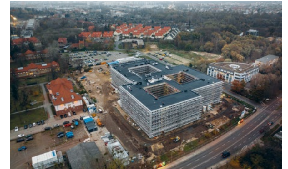
Baufeld Neubau Bundespolizeipräsidium in Potsdam
