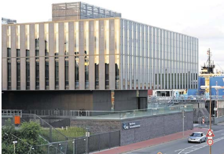
Weitreichende Folgen hatte ein Kurzschluss, der sich am Sonnabend im Maritimen Sicherheitszentrum (Bild) ereignete: Vierorts fiel der Strom aus, weil der Defekt vier Hauptstränge der EWE lahm legte. Foto: Koppe
