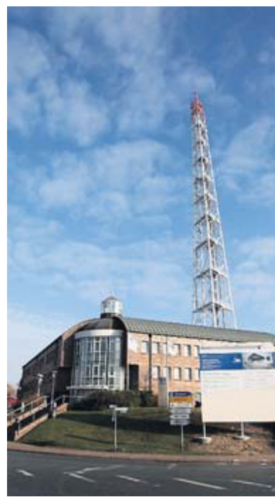
Ein Bauschild am Wasser- und Schiffsamt weist auf den Neubau hin, der zurzeit rechts neben dem Klinkerbau gebaut wird.
