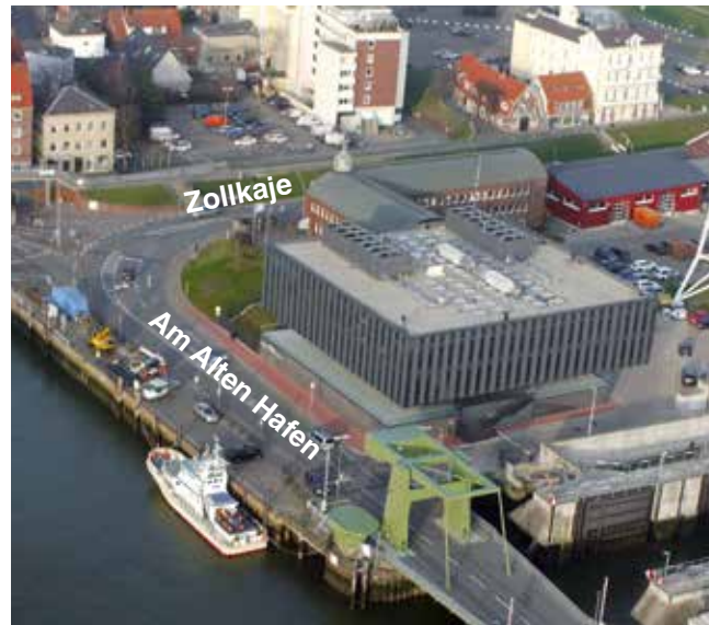
Am Alten Hafen 2, 27472 Cuxhaven
