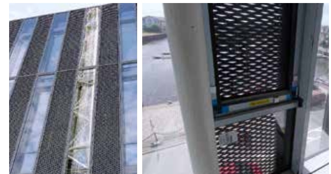
Ansicht Fassade von Außen (links) und Blick von Innen (rechts)
